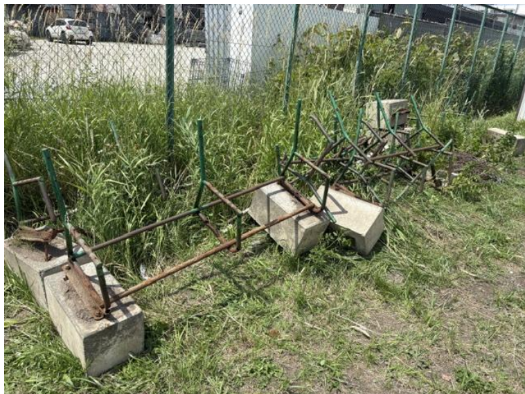
ベンチ土台（一部、コンクリートと鉄部分結合）
